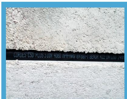
Innenansicht einer Schachtfuge (Lastausgleich) nach Montage (CSD Plus 3)
