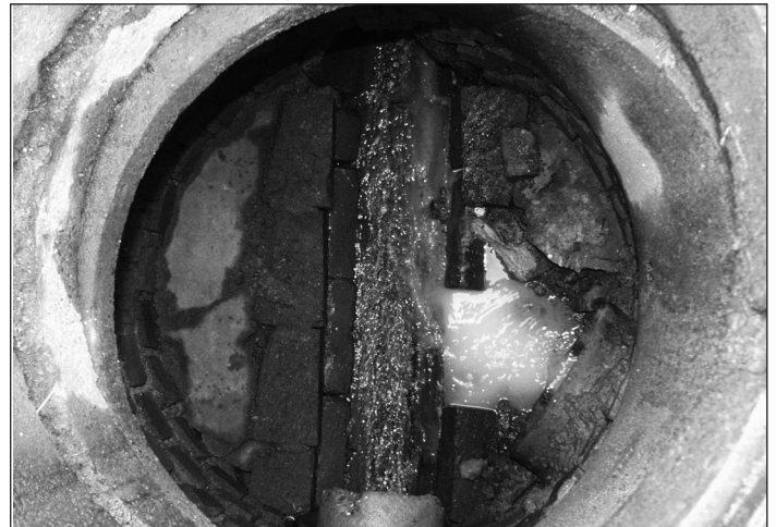
Abbildung 4: Fehllanschluss
