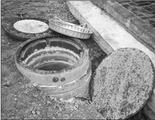
Abbildung 3: Schacht mit korrekt vorbereitetem Höhenausgleich
