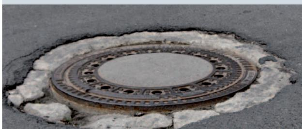
BILD 2: Typische Mängel bei eingebauten Schachtabdeckungen
