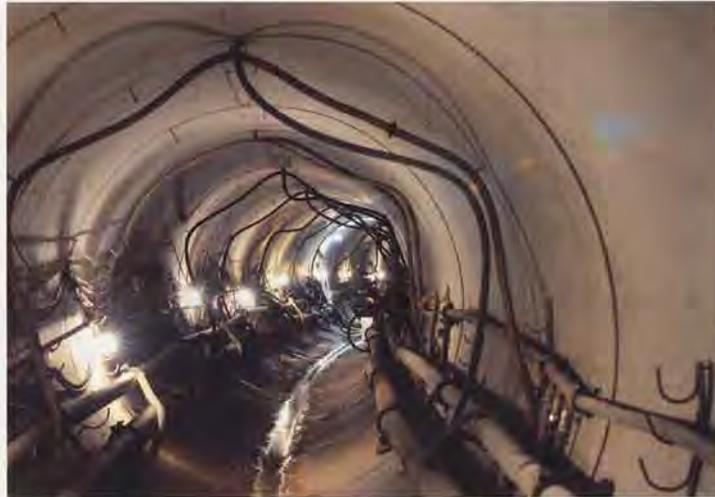
Blick in den bereits eingebauten Rohrstrang - der Stauraumkanal wurde mit einer doppelten Kurvenfahrt (Radius je 500 m) eingebaut. | Foto: Brochier Spezialtiefbau GmbH
