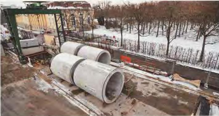
Vor der Startgrube lagern die vorbereiteten Stahlbetonrohre. Die 26 Tonnen schweren Rohre werden über eine Krananlage in die Grube abgesenkt. | Foto: Brochier Spezialtiefbau GmbH
