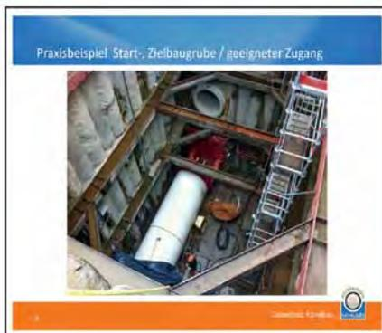
Im Regelwerk festgelegt: Baugruben müssen in allen Bauphasen mit geeigneten Zugängen sowie Absturzsicherungen versehen werden.
