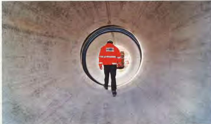
Zur Gütesicherung gehört auch eine Sichtprüfung der 4 m langen FBS-Stahlbetonrohre DN 2.500 vor dem Einbau der Rohre. | Foto: Brochier Spezialtiefbau GmbH
