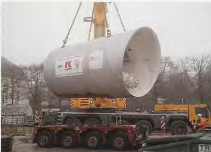
Die fast 50 Tonnen schwere Tunnelbohrmaschine wurde mit Hilfe eines Schwertransporters aus Hamburg nach Ansbach gebracht und traf dort am 19. Dezember 2012 auf der Großbaustelle an der Promenade ein. | Foto: Brochier Spezialtiefbau GmbH
