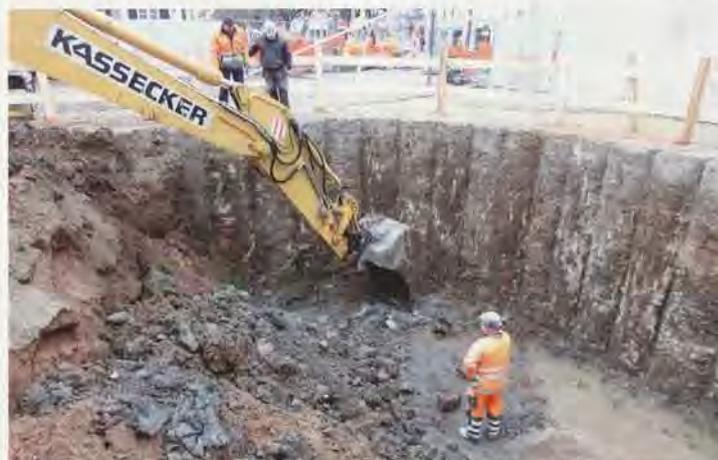
Insgesamt wurden sieben Baugruben für die Vortriebsmaßnahme mit Flächen zwischen 50 und 400 m<sup>2</sup> erstellt. Die Baugruben wurden mit überschnittenen Bohrpfehlwänden gesichert. | Foto: Franz Kassecker GmbH
