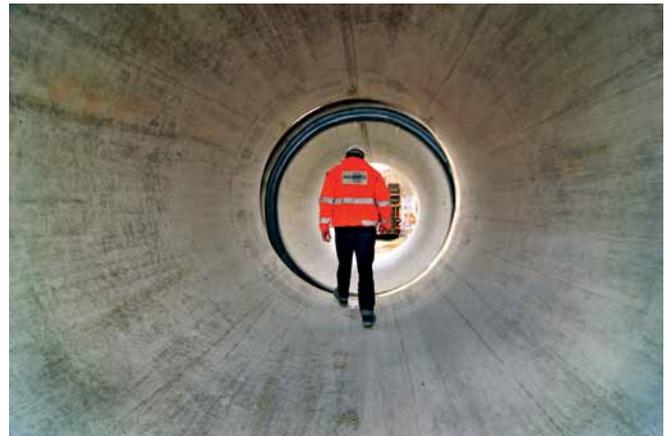
Zur Gütesicherung gehört auch eine Sichtprüfung der 4 m langen Stahlbetonrohre DN 2500 vor dem Einbau der Rohre.
