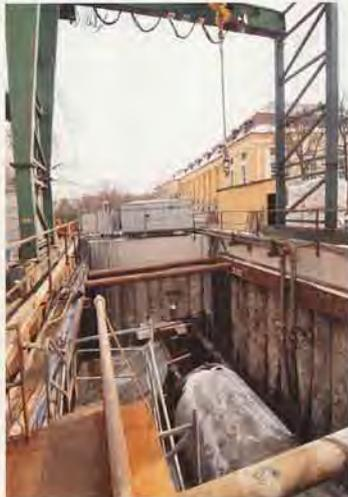
Die einzelnen Stahlbetonrohre wurden über die Startgrube mittels Hydraulikstempel mit bis zu 800 Tonnen in die Vortriebsstrecke eingepresst. | Foto: Brochier Spezialtiefbau GmbH
